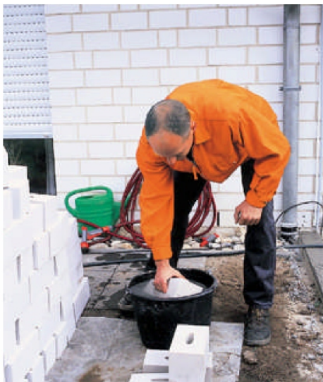
Bei starker Hitze ist das Vornässen der Mauersteine zu empfehlen.
