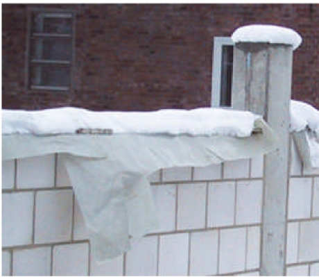
Das frische Mauerwerk ist vor Frost zu schützen, z.B. durch Abdecken mit Folie.
